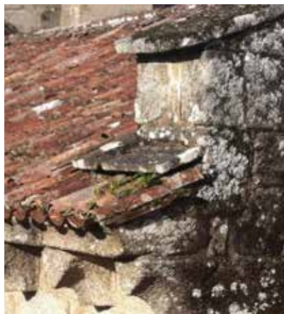
La cubierta se repondrá con teja cerámica
