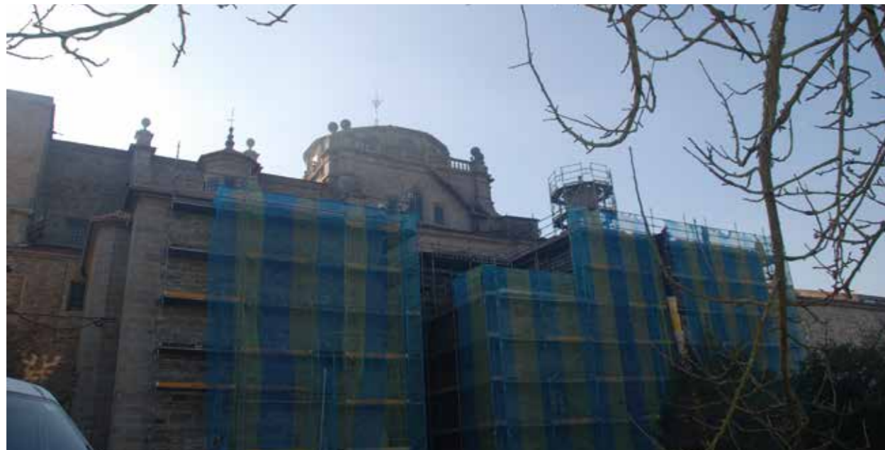
Se está realizando una limpieza y rejuntado de las fachadas
