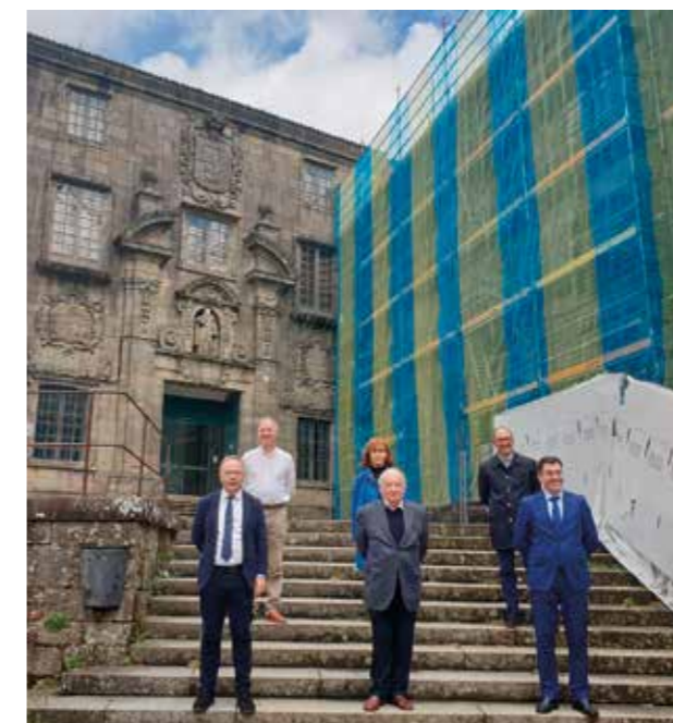
Visita del conselleiro de Cultura y el alcalde de Santiago a las obras
