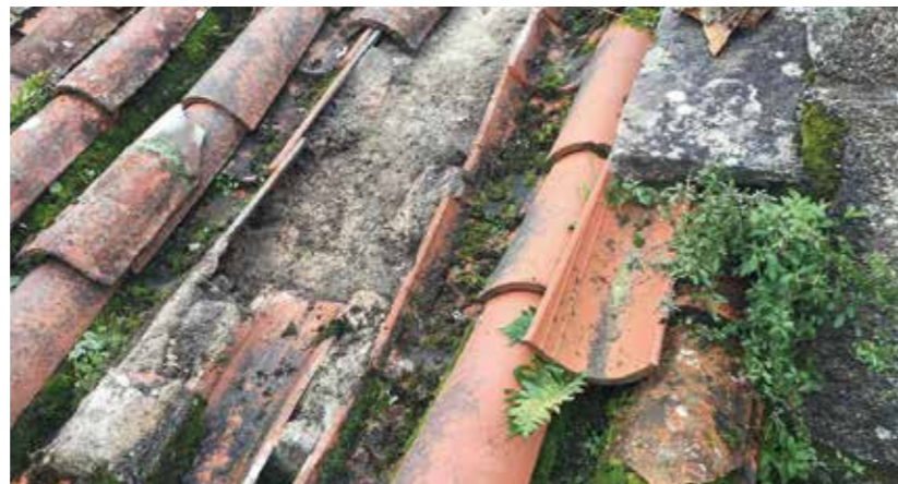
Las humedades están provocando daños tanto en las fábricas como en el interior
