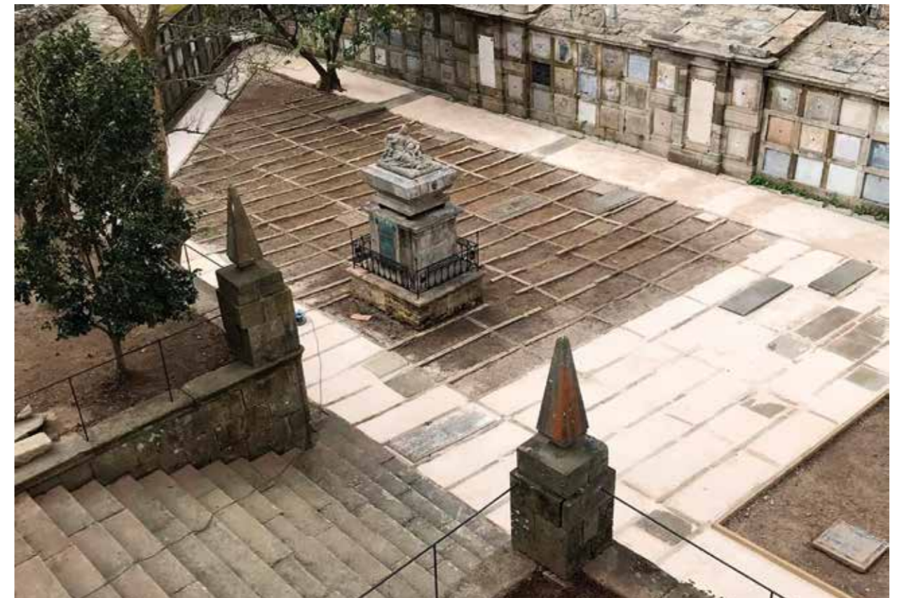
Se mejoró el pavimento de piedra y la escalinata se limpió y se consolidó
