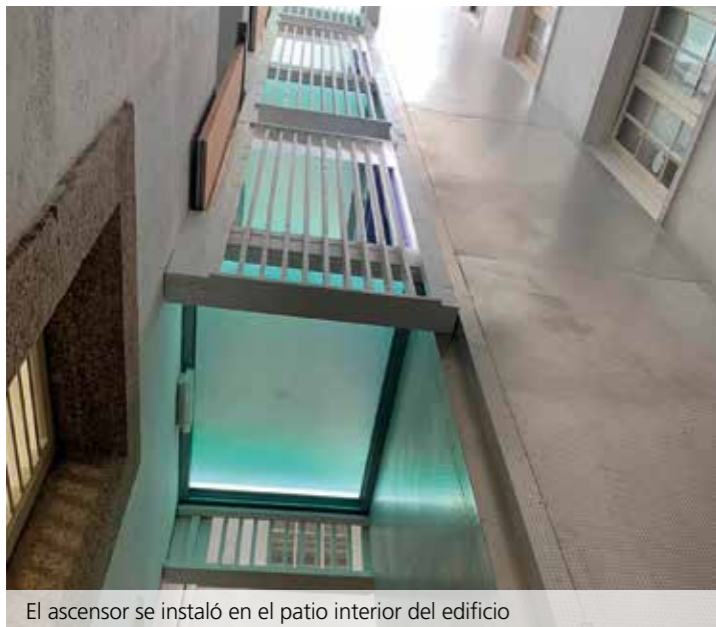
Dispone de una batería que permite realizar hasta cien viajes en el caso de cortarse el suministro eléctrico
