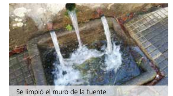
Se colocó una gárgola para favorecer la evacuación del agua de la lluvia
