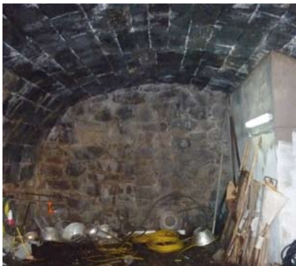
> Subsuelo del edificio antes de la intervención
