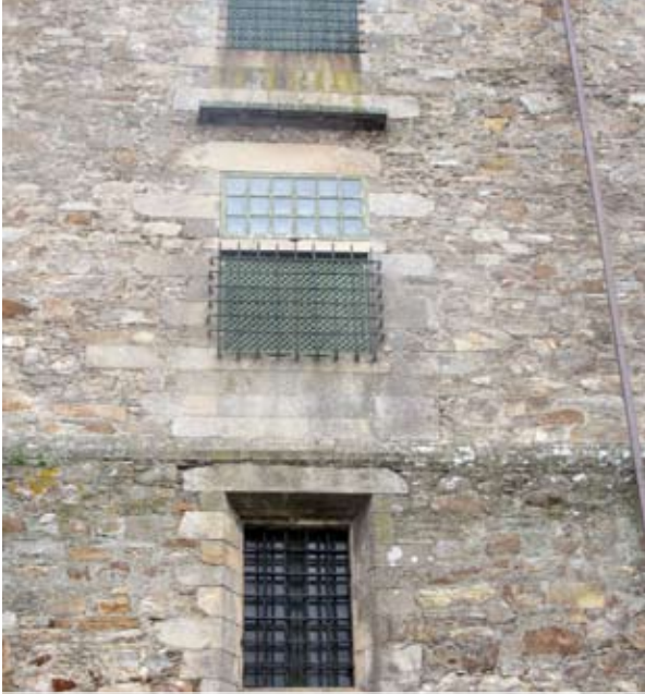
> Las rejas antes de la restauración
