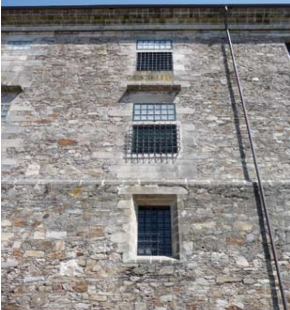
> Las rejas después de la restauración
