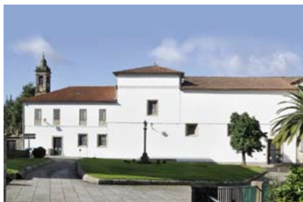
> La fachada este de la iglesia de la Orden Tercera Franciscana una vez realizada la intervención
