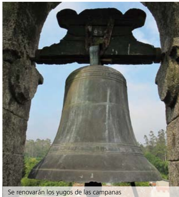
El agua entra en la torre del campanario y en su entorno
