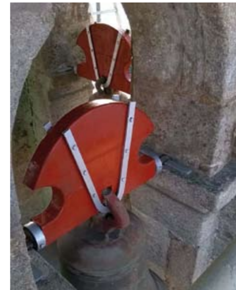
Tanto en la fachada como en el campanario de la iglesia prolifera la vegetación
