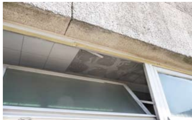
La entrada del agua de la lluvia a través de las fachadas de piedra y de las cubiertas es un problema general del edificio
